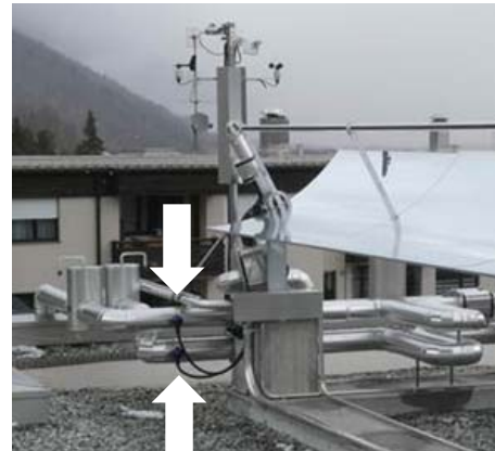
Abbildung 4: Position der Kollektorfeld-Temperatursensoren
