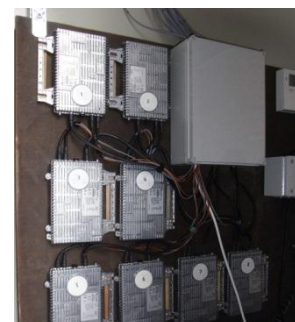
8 Modulwechselrichter
