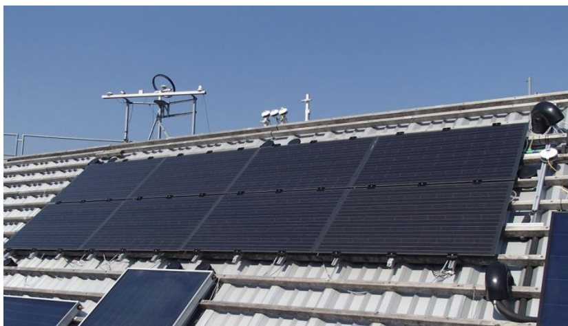
2 PV-Module (3.3 m 2 ) 6 PVT-Kollektoren (9.9 m 2 )
