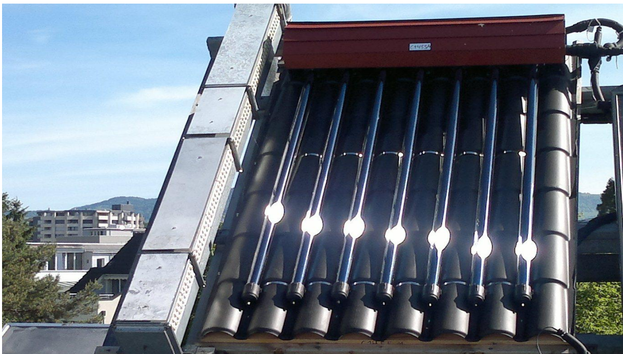
Abb. 4: Reflexionen an einem Vakuumröhrenkollektor. Anstelle eines einzigen Reflexionspunktes wird auf jeder Röhre ein einzelner Lichtpunkt reflektiert. Bei grossen Kollektoren entstehen lange Linien ähnlich zu Lichterketten. Die Reflexionen sind schwächer, können dadurch aber sehr viel länger dauern als bei einem Flachkollektor.
